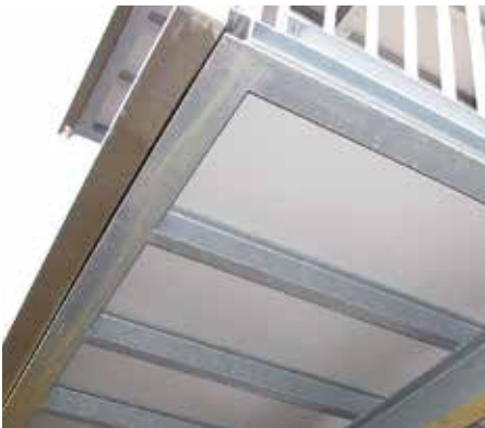
SUBESTRUCTURA/ELEMENTO DE SOPORTE
